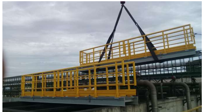
Passarela de Transposição de Dutos e de Acesso a Válvulas e Instrumentação - Petrobrás
