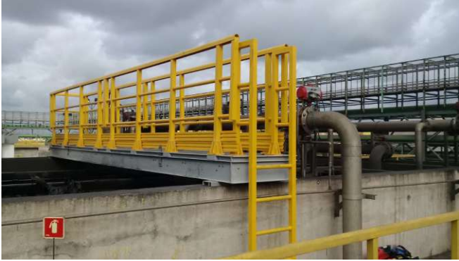
Passarela de Transposição de Dutos e de Acesso a Válvulas e Instrumentação - Petrobrás
