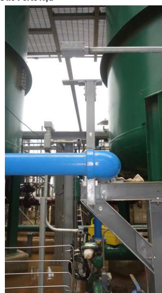
Suportes de Tubulações e Instrumentação em Fibra de Vidro Instalados no Porto Açu
