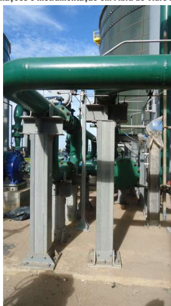
Suportes de Tubulações e Instrumentação em Fibra de Vidro Instalados no Porto Açu
